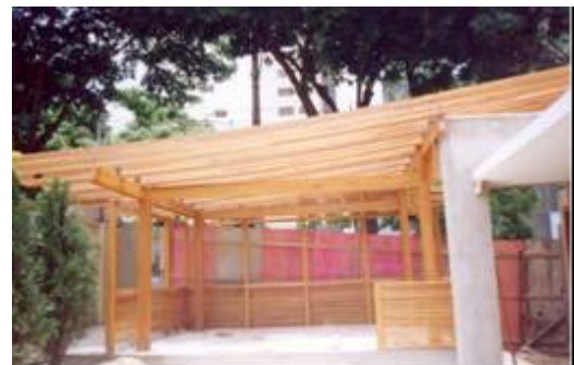
Figura 3. Estructura del restaurante en vigas curva. Fuente: Azevedo Júnior
