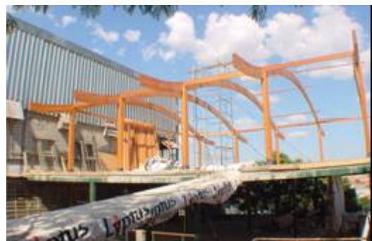
Figura 2. Cubierta del almacén industrial con vigas curvas de MLC de eucalipto. Fuente: ESMAD - Tecnología en Estructuras de Madera Colada.
