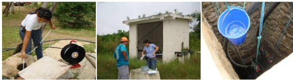
Figura 6. Inventariado de Pozos.
